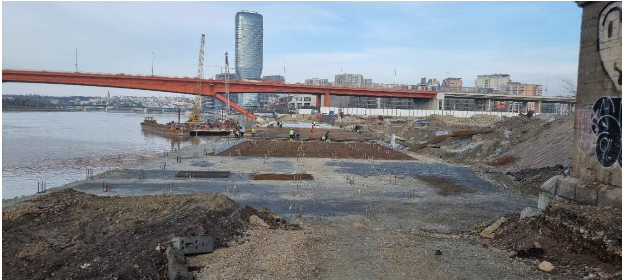
Слика 2.: Радови на II фази реконструисања обалоутврде
